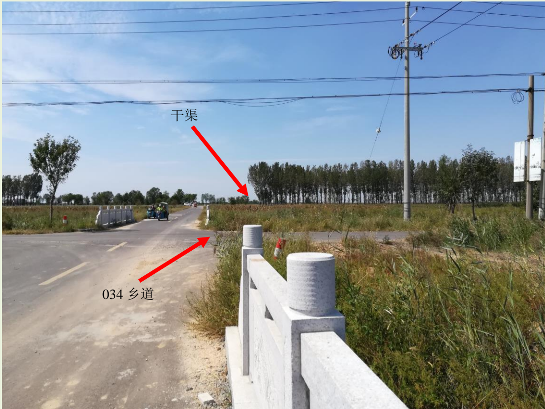
8#计量站西侧定向钻深穿的 034 乡道和干渠
